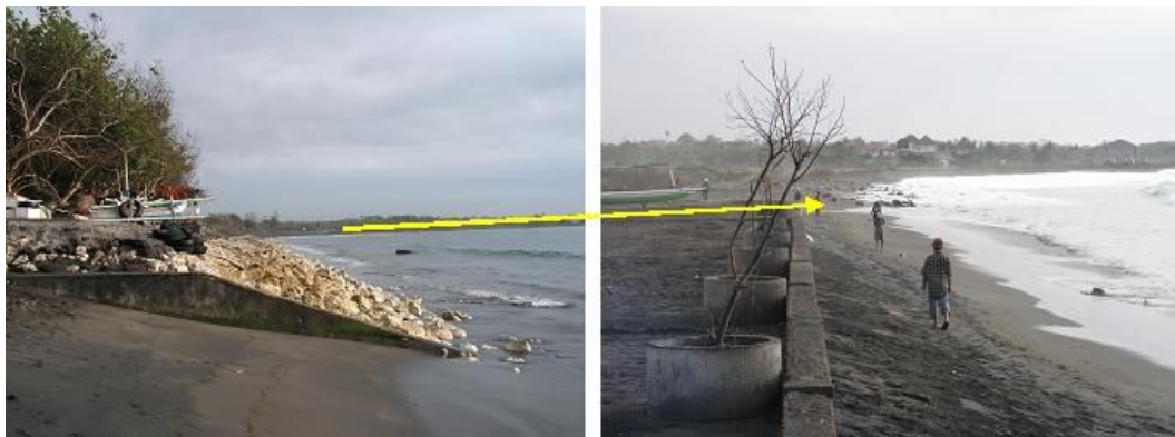
Figura 9. Esfuerzos de protección costera para proteger el turismo, y mientras tanto, la costa adyacente tiene una protección mínima (Prasetya (2006) en FAO (2007))
